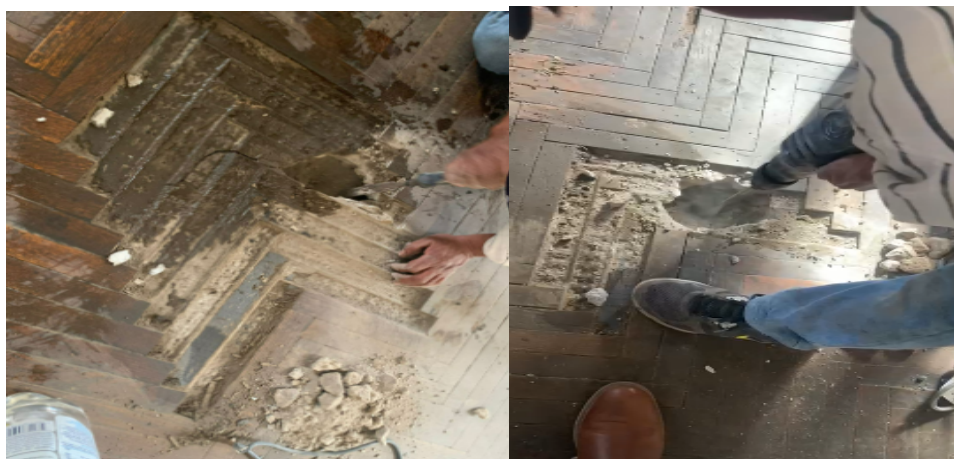
Figura 5. Exploraciones de la estructura
