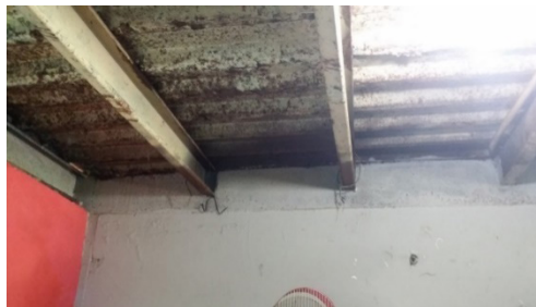
Figura 6. Losas de material metálico sin mantenimiento.
